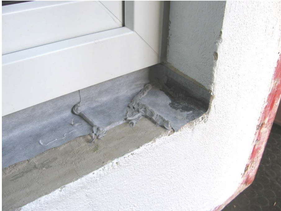
Bild 3 Äußere Abdichtung mit Silirub PRO N + Rundschnur-PE (seitlich und oben) und Fensterdichtband Außen + Soudaseal 215 LM (unten). Fensterbank noch nicht montiert.
