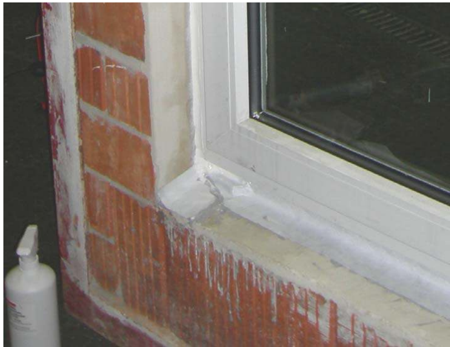
Bild 1 Abdichtung innen mit Acryrub PRO W + Rundschnur-PE (seitlich und oben) und Fensterdichtband Innen + Soudaseal 215 LM (unten).
