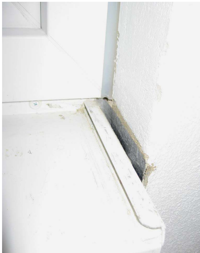
Bild 4 Aluminiumfensterbank montiert. Seitliche Abdichtung zwischen Endstück und Leibung noch nicht ausgeführt.
